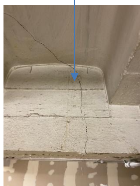
Figure 4 - Localisation des fissures observées au niveau -2
